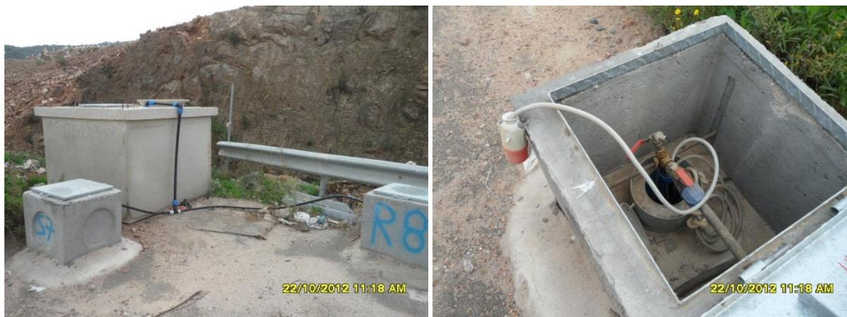
Figura 1: Piezometri per il monitoraggio delle acque sotterranee esistenti
